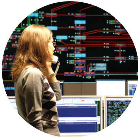
Operadora del centro de control eléctrico (Cecoe)
