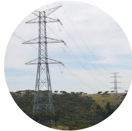
^ Línea de interconexión con Portugal
