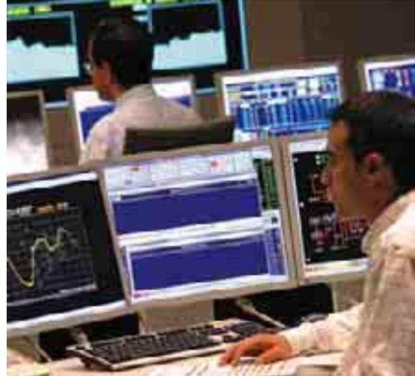
correspondientes a variables analógicas (potencias activas y reactivas en la red y en los nudos de generación y consumo, valores de las tensiones, etc.), 25.000 a variables digitales (posición de interruptores y seccionadores, etc.) y la emisión de órdenes de telemando correspondientes a 4.500 variables.
