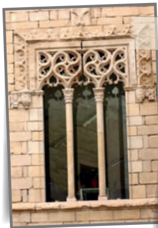
Ventana gótica del palacio Ardid.
